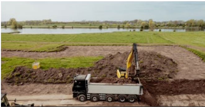
De klei wordt met een kraan afgegraven en met vrachtwagens of dumpers in schepen geladen (foto van een ander project)
